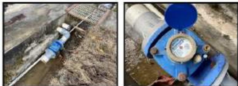
**Gambar 1. Pemasangan Alat Ukur Debit/Laju Alir Air Limbah**
